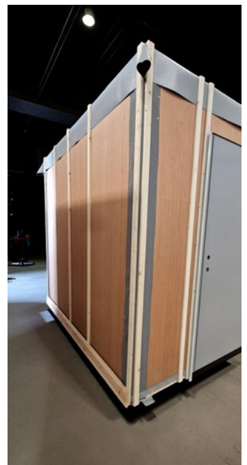
Før trekledningen er påmontert
